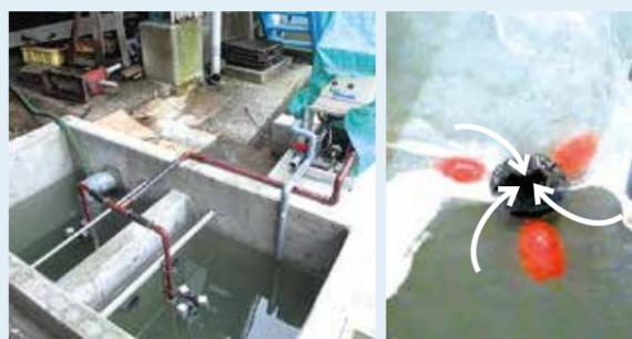
1 グリストラップ内に設置したスキマーが、油脂分・浮遊物混入排水を吸い込み、オイルトリックに送り込みます。
